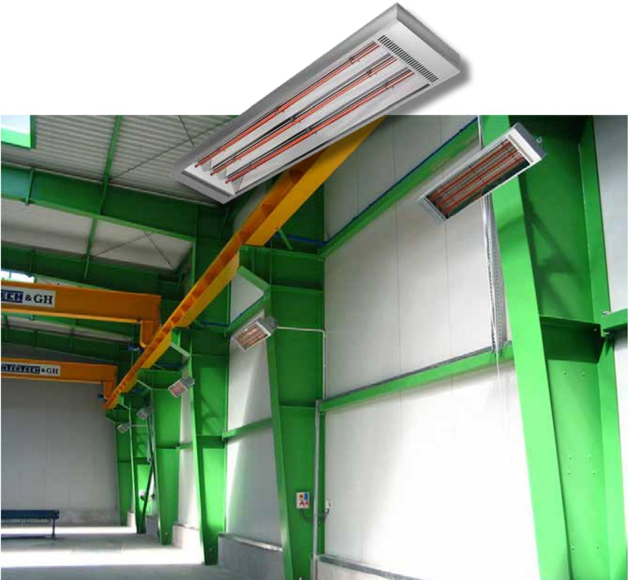
**Energolnra Industry** bietet eine energieeffiziente Heizung für die meisten Anwendungen und Arbeitsumgebungen mit hohen Decken (ca. 3–40 m). Durch Wärmestau in Böden, Wänden und anderen Oberflächen kann die Lufttemperatur gesenkt werden, was zu Energieeinsparungen von 25–50 % bei gleichem Wärmegefühl führt.
