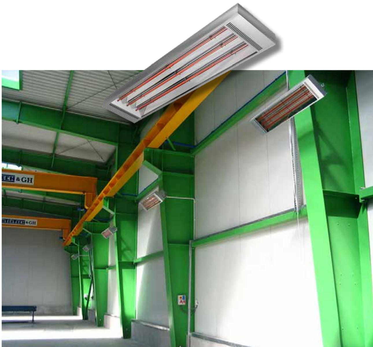
**Energolnra Industry** osigurava energetske učinkovito grijanje i primjenu u radnim prostorima visokih stropova (cca 3-40 m). Akumulacija topline u podu, zidovima i drugim površinama, omogućava sniženje temperature zraka prostorije, što daje uštedu energije od 25-50%, uz isti komfor grijanja.
